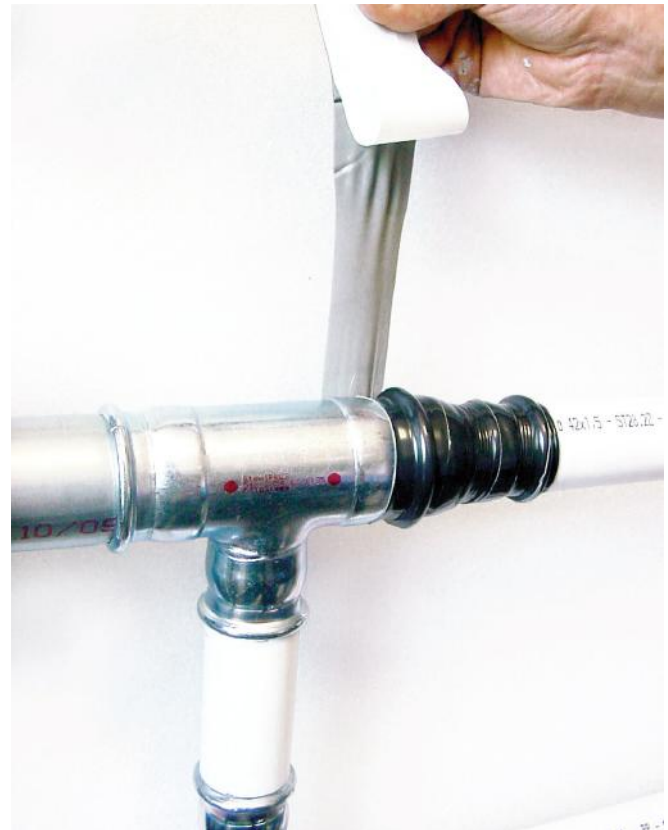
Figura 38 - Protezione dei raccordi con nastro isobutilico
