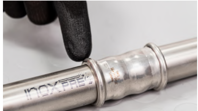
Figura 33 - Controllo della pressatura
