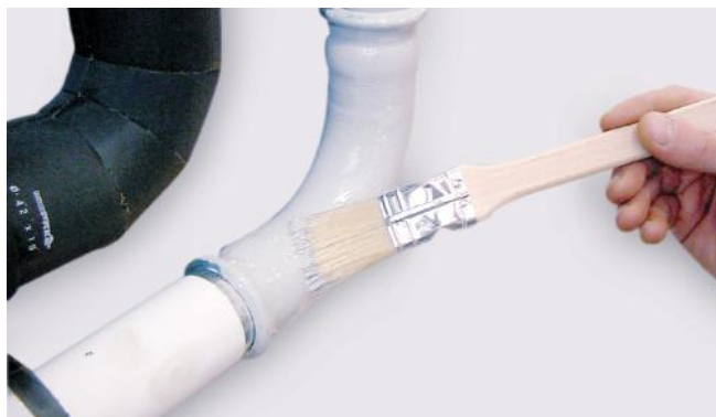
Figura 37 - Verniciatura raccordi e tubazioni con primer
