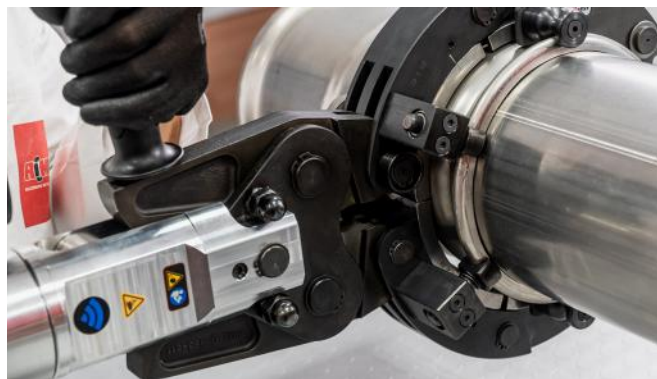
Figura 35 - Assemblaggio pressatura n°2
