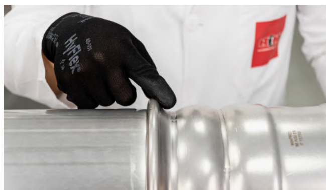
Figura 36 - Controllo visivo pressatura Oversize
